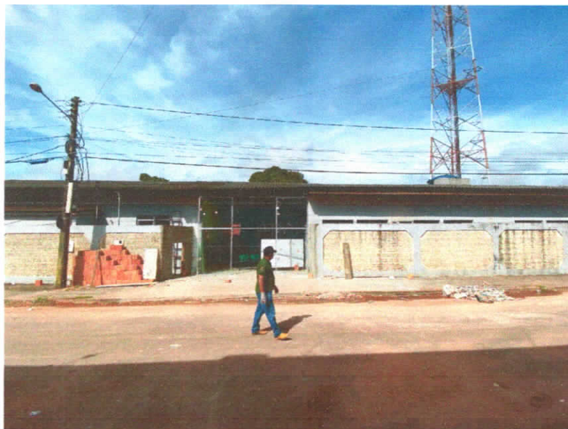
Figura 1 – Vista frontal da edificação
